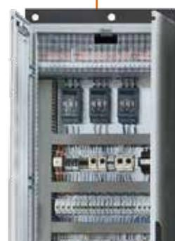
Tablero iluminación. Contactores de potencia y sistema de control.
