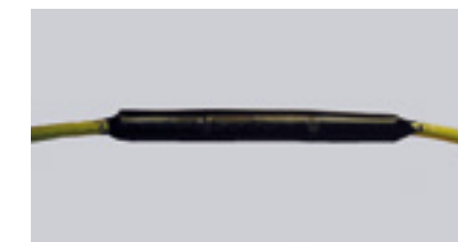
3. Una vez curada la resina, retiro del molde y energización del sistema.
